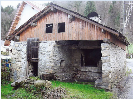
Four de Tigneux construit en 1837
